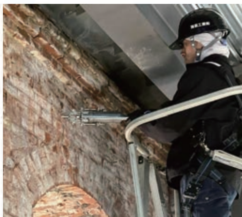
エポキシ樹脂注入
