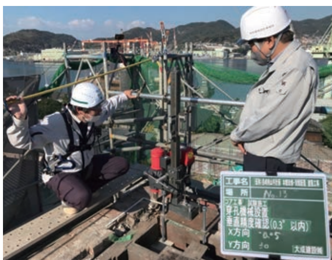
煉瓦壁内への鉄筋挿入工事の様子
