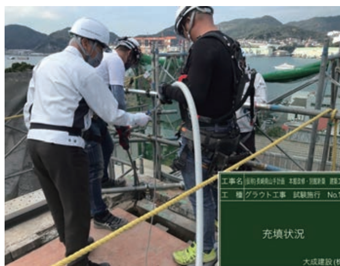
煉瓦壁内への鉄筋挿入工事の様子
