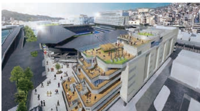
商業棟屋上俯瞰
